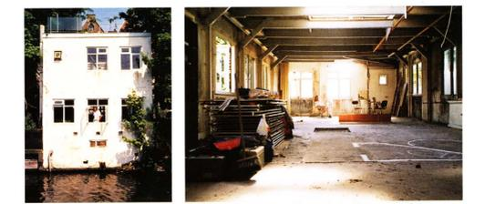
Den Blick auf die Korte Eilandgracht wollte Tijmen Ploeg freischlagen. Dafür ließ er die Südfassade fast ganz abtragen. Innen entfernte er die Zwischenwände, so dass ein weiter Raum zum Vorschein kam. Einbauten wurden in Kreide markiert.
